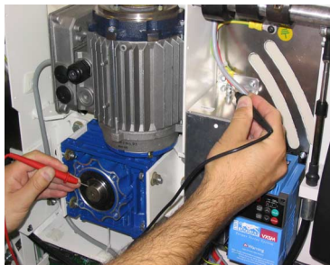
Fig. 11.3a Essai de continuité à la terre
