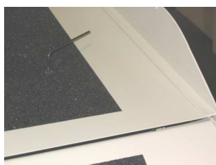
Fig. 8.3a Pose du plateau de plate-forme
