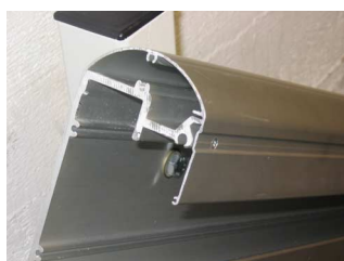
Fig. 8.1a Pose du couvercle de rail
